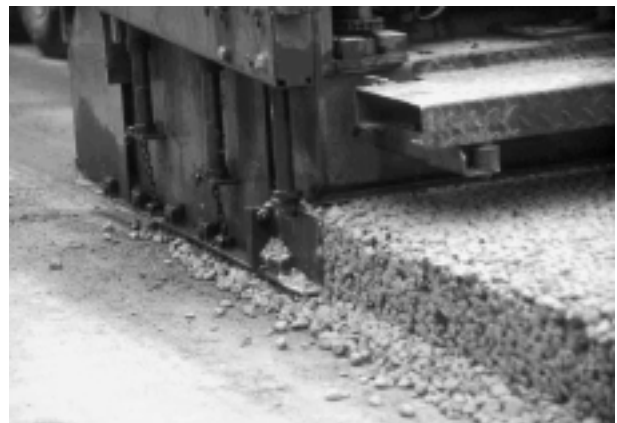
Bild 2: Einbau der DBT mit Straßenfertiger
