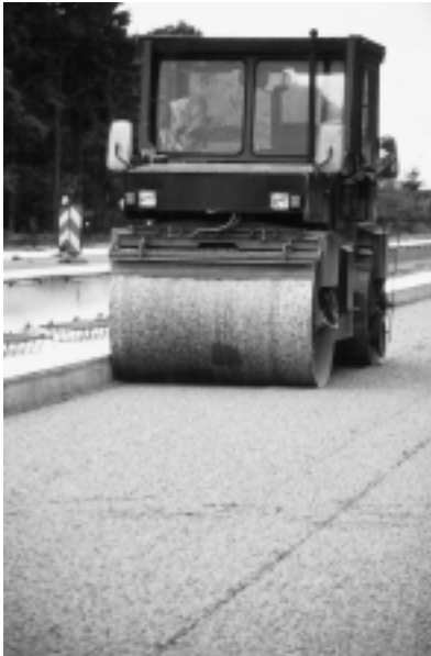
Bild 5: Abwalzen der DBT mit Glattmantelwalze ohne Vibration
