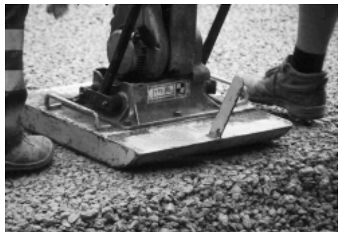
Bild 4b: Einrütteln der Querfugen
