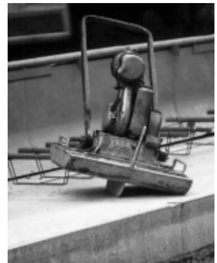
Bild 4b: Einrütteln der Querfugen
