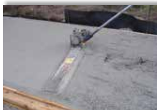
Benzin- oder Strom- Glätt- Rüttelpatzche
