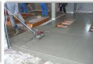
Benzin- oder Strom- Glätt- Rüttelpatzche
